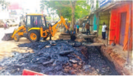
యలమంచిలి, మార్చి 17 ప్రభాతవార్త యలమంచిలి పట్టణంలో మెయిన్ రోడ్డుకు ఇరువైపులా ఉన్న ప్రధాన డ్రైనేజీ కాలువ పూడికతీత పనులను శుక్రవారం నాలుగో రోజు కూడా కొనసాగించారు. ఈ పూడిక తీత పనులు ఎప్పుడు రోడ్డుకి ఒక సైదు మాత్రమే తీస్తున్నారని రెండోవైపు ఎప్పుడూ పూడికతీత తీయకపోగా అటువైపు కన్నెత్తి చూసిన దాఖలాలు లేవని చలువురు ఆరోపి
